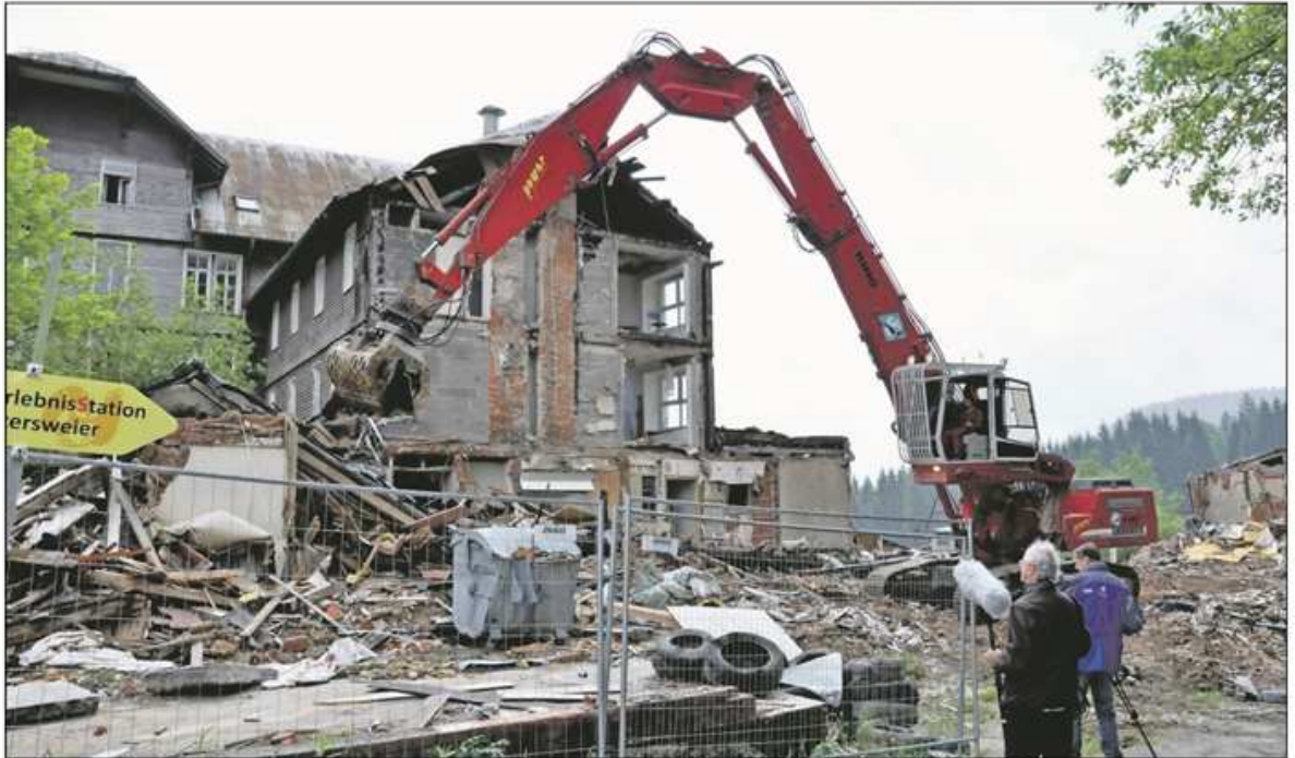
Juni 2013: Ein Bagger sammelt den Bauschutt ein. Zum Komplettabbruch fehlt die rechtliche Grundlage.
