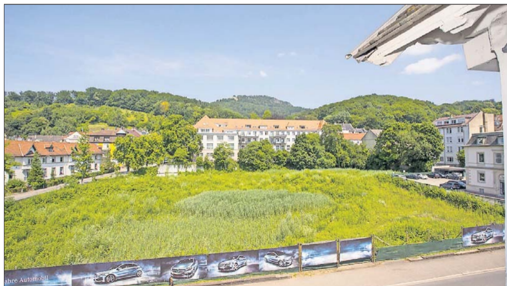
Die Brache am Eingang zur Innenstadt wird bebaut: Der Bauausschuss hat grünes Licht für das vorgesehene Hotel mit Ärztehaus und Wohnhaus gegeben.
