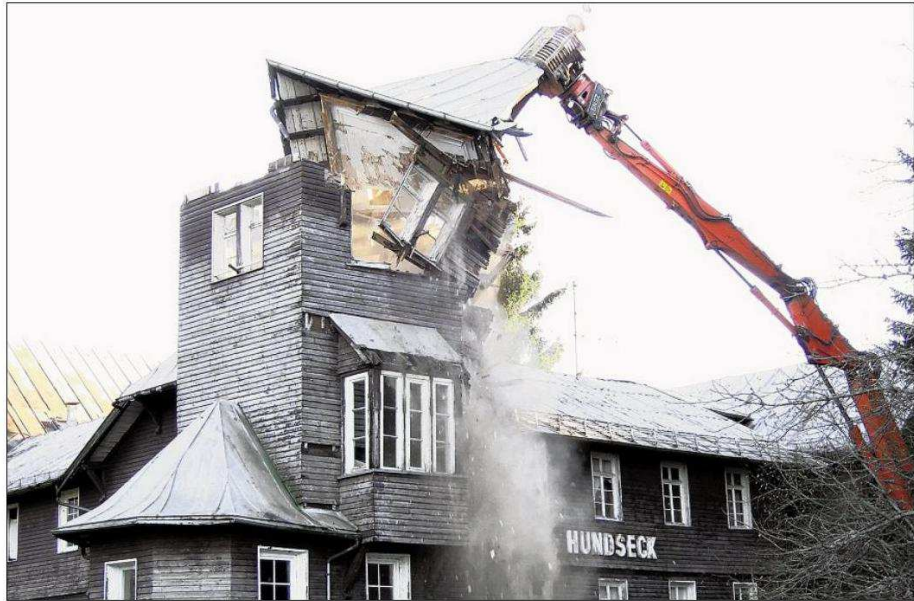
UNENDLICHE GESCHICHTE: Bereits im November 2012 wurden große Teile des ehemaligen Kurhauses Hundseck abgerissen. Der Fall beschäftigt aber Politik und Behörden nach wie vor. Ein Abbruch der restlichen Ruine steht aus. Archivfoto: Coenen
