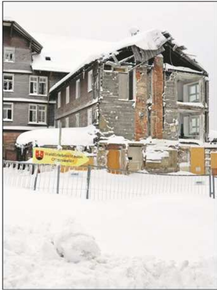
Vor langer Zeit ein stattliches Hotel: Heute ist das Kurhaus Hundseck nur noch eine Ruine.
