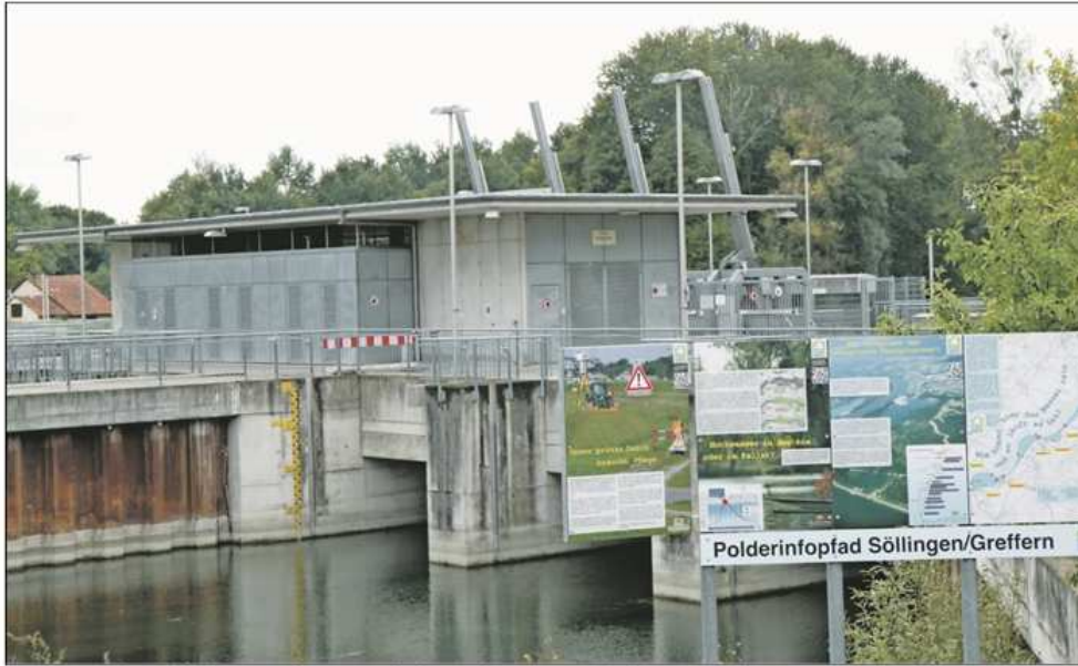
Im Rahmen des Polderbaus wurde 1999 auch eine zweite Brunnengalerie zur Grundwasserregulierung installiert.
