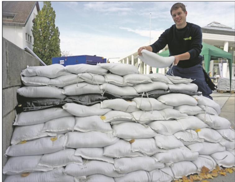
Kurzer Damm aus Sandsäcken errichtet: Das THW demonstriert vor dem Bürgerhaus Neuer Markt seinen Einsatz im Hochwasserfall. Fotos: Eiermann
