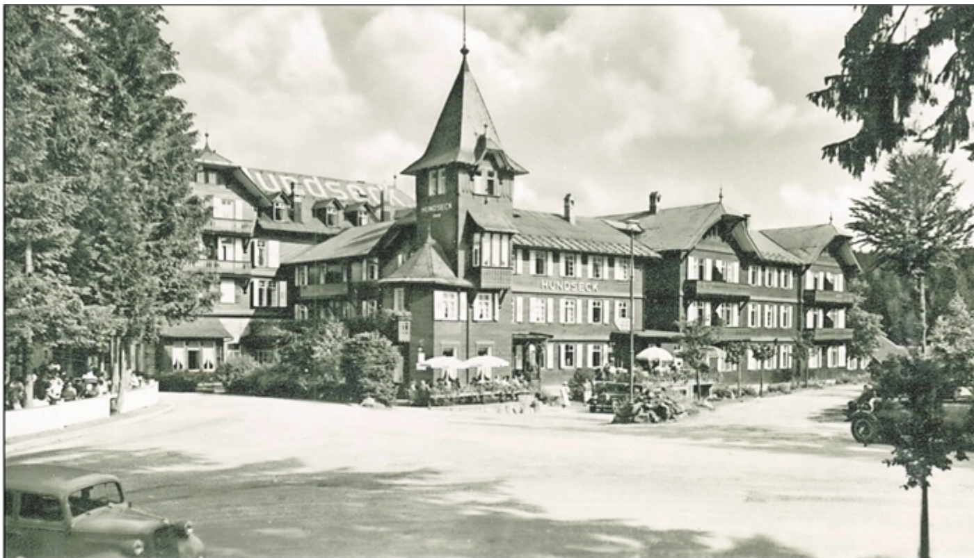
Ein Bild aus besseren Zeiten: Das Kurhaus Hundseck zu Beginn des vorigen Jahrhunderts.
