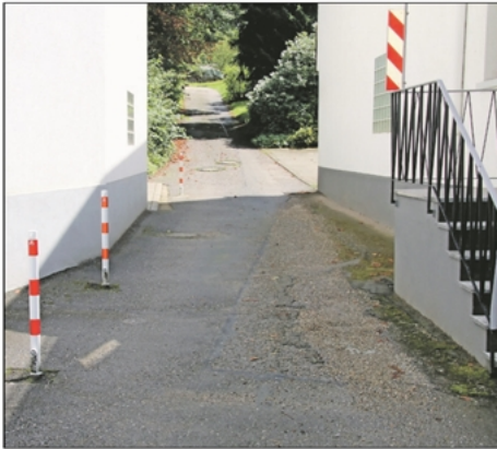
Unter anderem geht es in der Petition um die Pfosten, die die Fahrbahn verengen und die Zufahrt erschweren.
