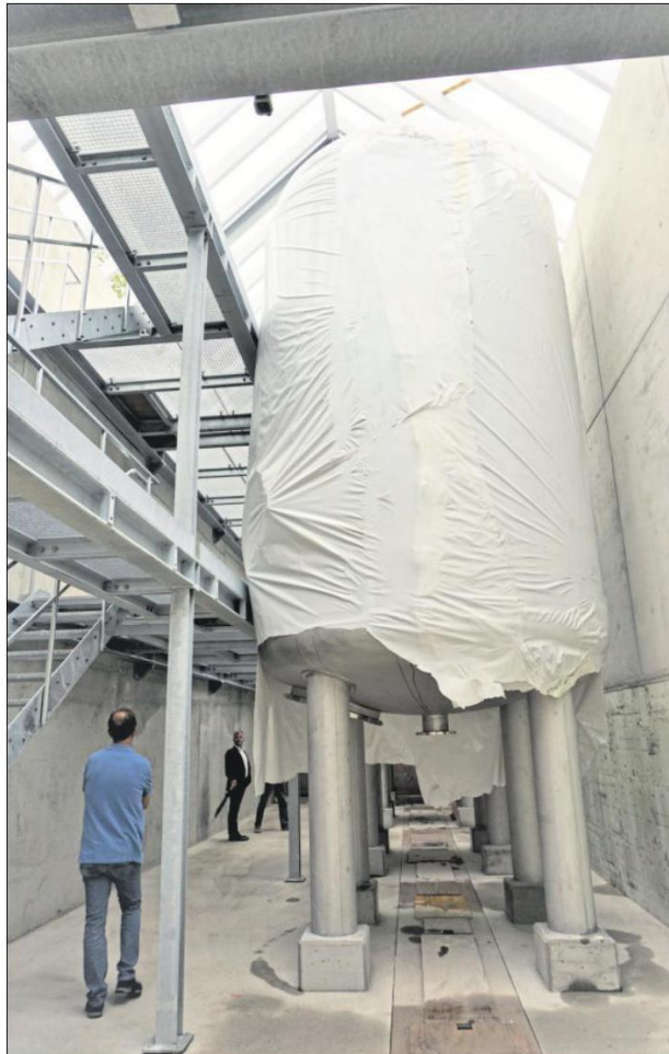
AUFRÜSTUNG DES WASSERWERKS RAUENTAL: „Eine Maßnahme könnte der Einsatz von Filtern zur Reinhaltung von Trinkwasser sein“, erklärt Böhlen. Archivfoto: Collet
