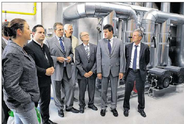
ÜBER DIE ENERGIEERZEUGUNG der Stadtwerke informierte sich Minister Alexander Bonde (Zweiter von links) in der Nahwärmezentrale in der Economatstraße. Foto: wv
