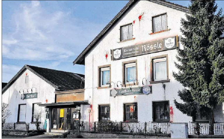
FARBVERSCHMIERT: Das „Rössle“ in Söllingen wurde in der Vergangenheit mehrfach beschädigt – ein Protest gegen die wiederholten Neonazi-Konzerte im Nebenraum der Gaststätte. Foto: Margull
