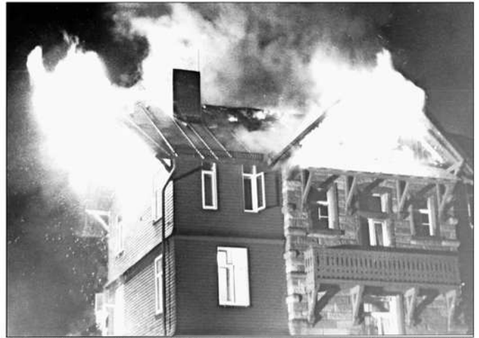
Ende der 70er Jahre wütete ein Großfeuer im damaligen Vorsorgeheim Hundseck. Nach der Sanierung steht dieser Gebäudeteil heute noch.
