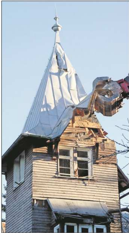
20. November 2012: Der Abbruchbagger schnappt sich den Blechhelm des charakteristischen Hundseck-Turms.
