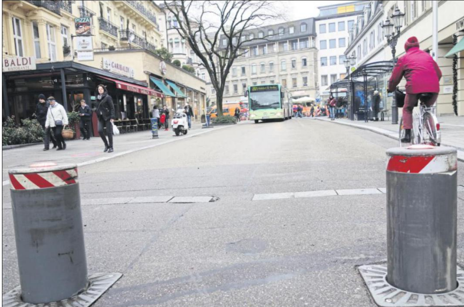
RUND UM DEN LEO KANN ES WEITERGEHEN: Der Gemeinderat genehmigte den Auftrag für die Oberflächengestaltung und die Sanierung der Luisenstraße bis zur Inselstraße. Die Arbeiten sollen nach der Winterpause im Februar beginnen. Foto: Rudolphi
