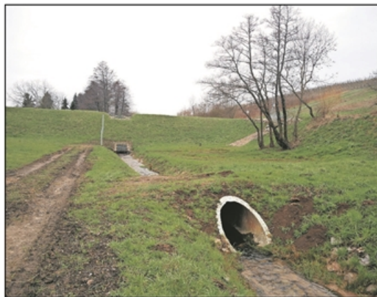
Der Damm des Hochwasserrückhaltebeckens 6 im Grünbachtal bleibt weitgehend stehen, ...
